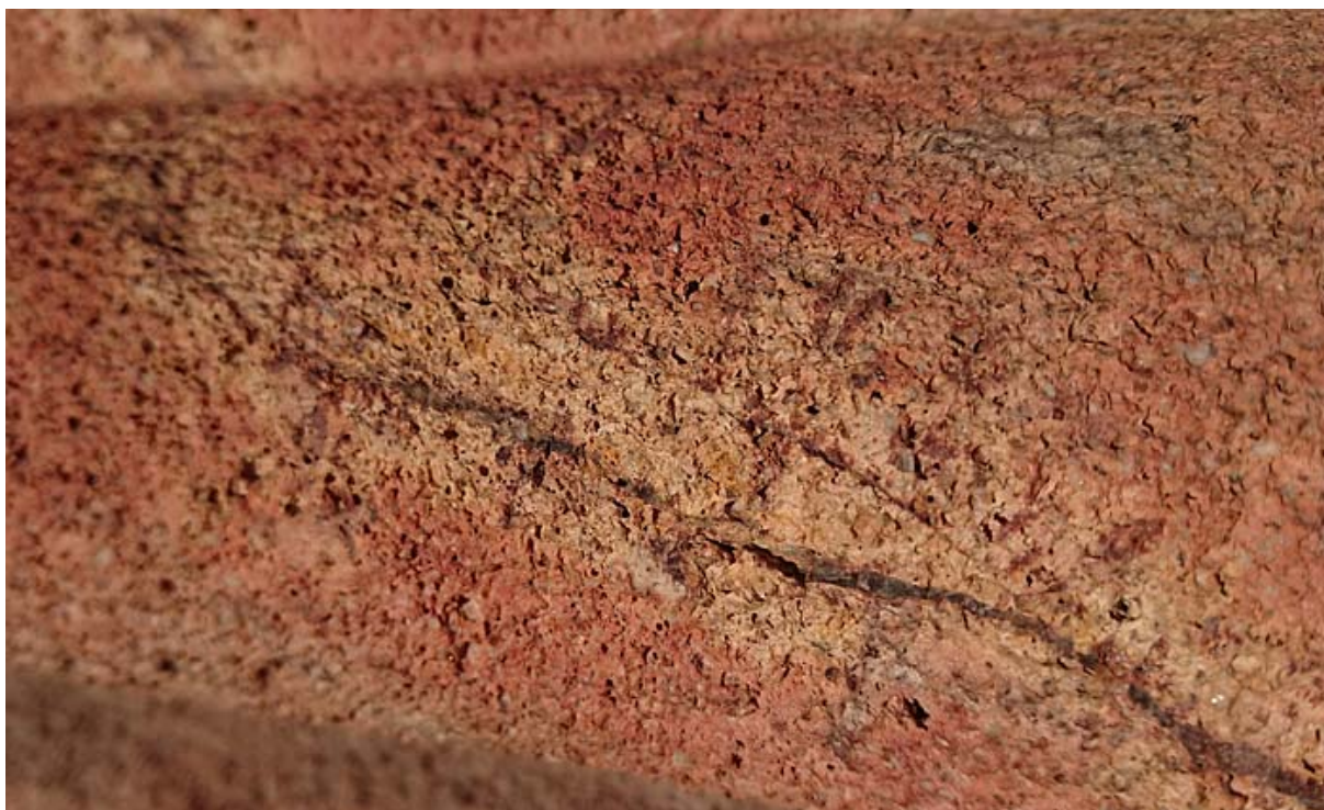
(Nahaufnahme mit Kluft/ Äderung am Eisenbahn-Obelisken)
